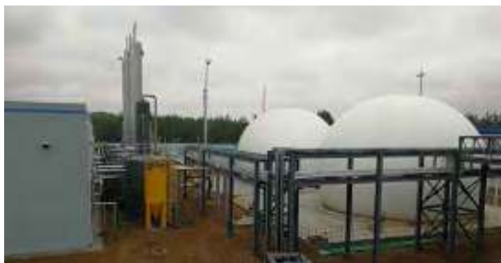
净化提纯现场
