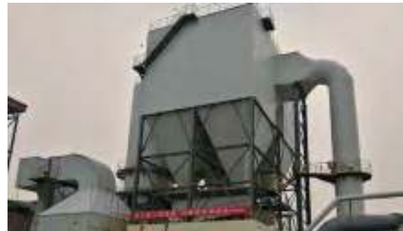
兖矿南屯电力 3x220t/h 流化床锅炉烟气超低排放改造工程
