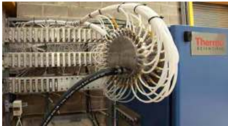
快速多点位生产泄漏 VOCs 磁质谱在线监测系统现场图片
