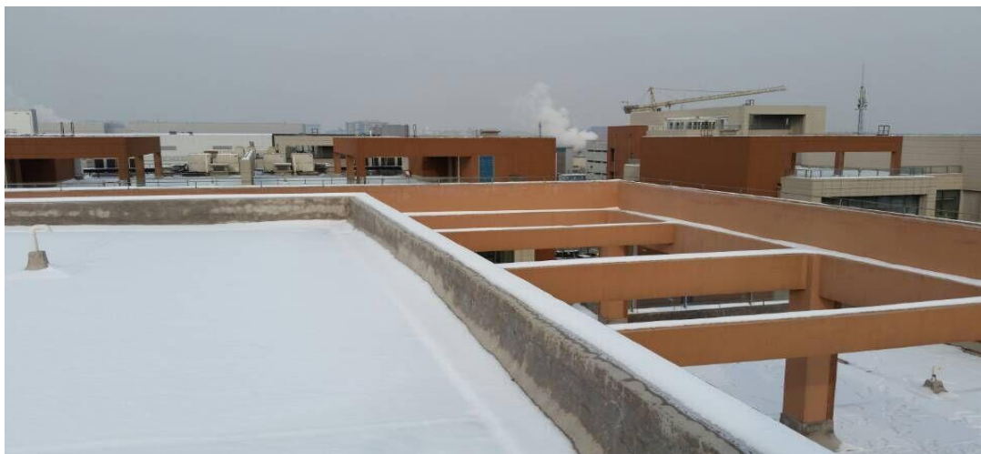
图 2.4.3 安装前屋顶图片
